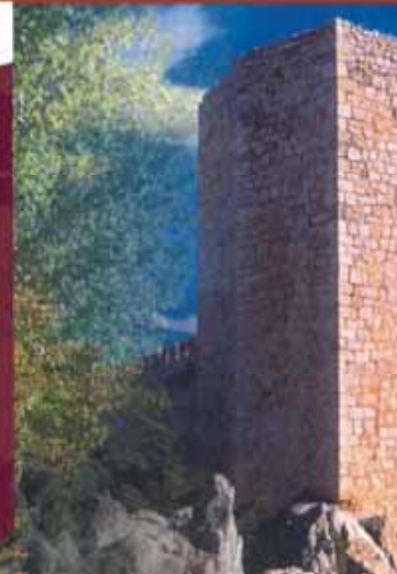
Detalle de un castiello medieval, mostrando las torres de la fortificación.
