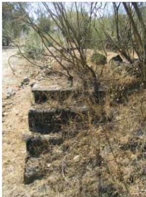
Restos de las instalaciones ferroviarias
